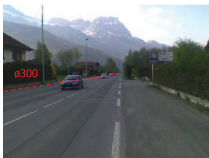
Photo 2 : Réseau EP les Iles Sud - RD13
